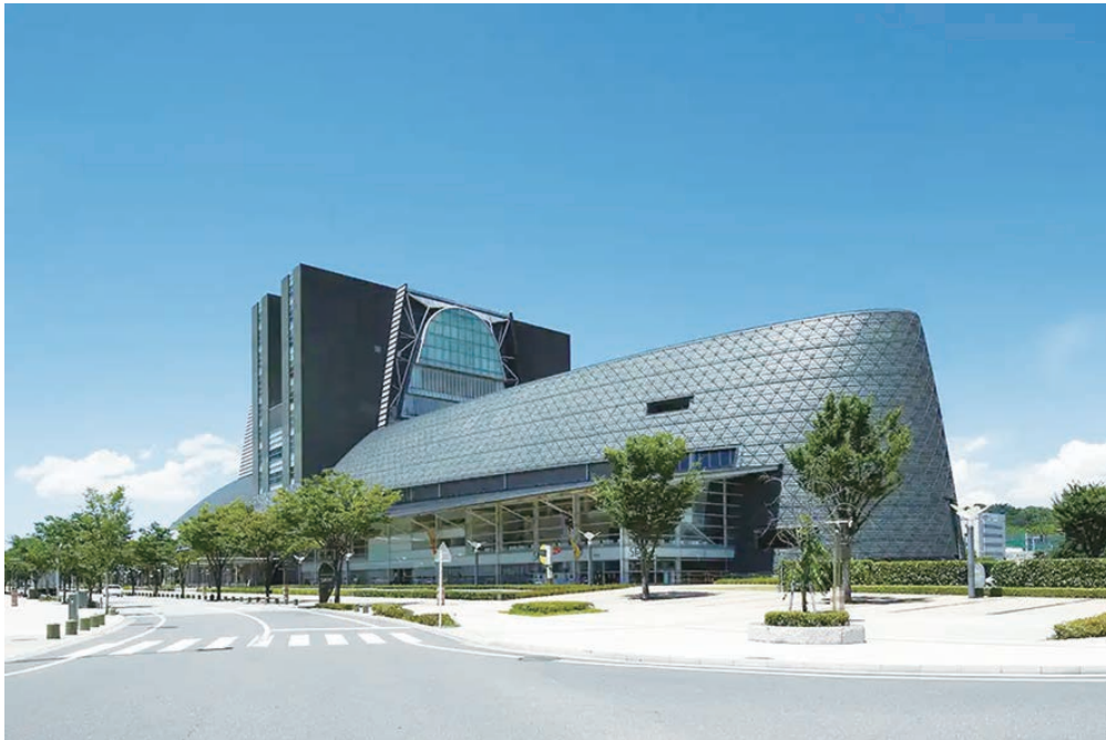
グランシップ GRANSHIP (静岡県コンベンションアーツセンター) (会議室等写真も含めて GRANSHIP HP より)
